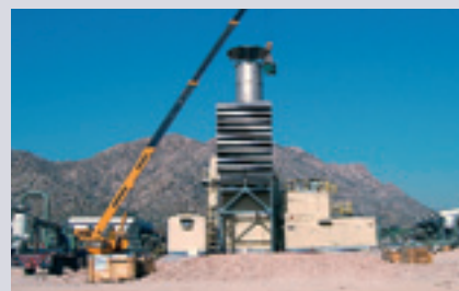
Пять ГПА-Ц-25С общей мощностью 125 МВт работают на КС «Хаваран»
