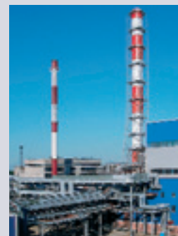
Современная парогазовая электростанция обеспечит Калининград электрической и тепловой энергией
