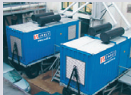
Дизель-генераторные установки SDMO Exel с двигателями MTU (DaimlerChrysler) установлены в специальных контейнерах
