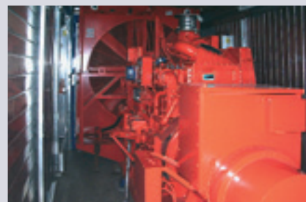
Установка Waukesha VGF24GL в блок-модуле «Континент»
