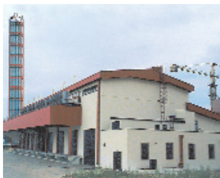
Фото 2. Общий вид технического комплекса Делового центра ООО «Мострансгаз»
