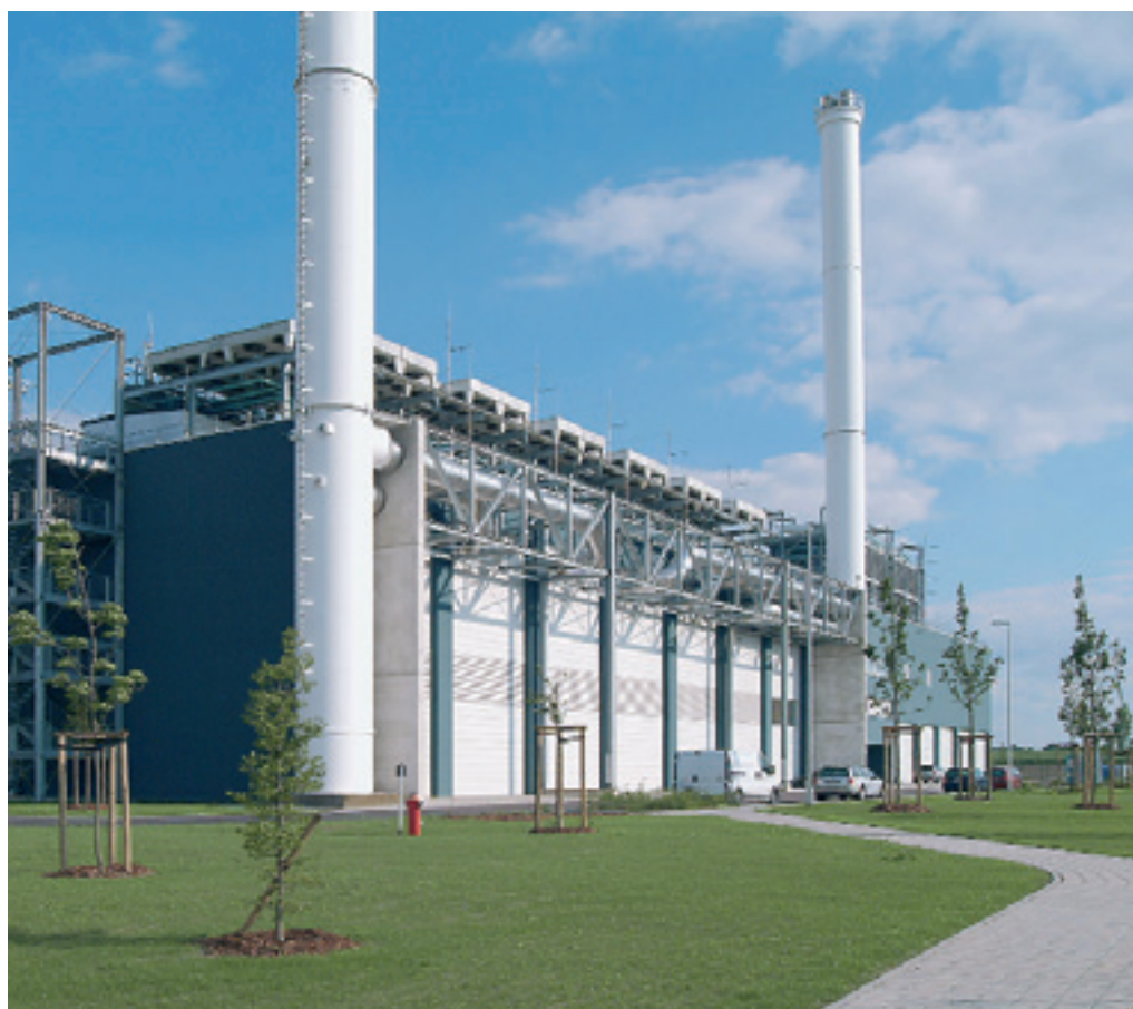
Фото 1. Центр энергоснабжения (EVC II)
