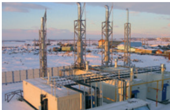
С Фото ТЭС (слева направо): «пиковая» котельная, генераторные установки PG750B и резервный дизель-генератор. На переднем плане – контейнер с НКУ
