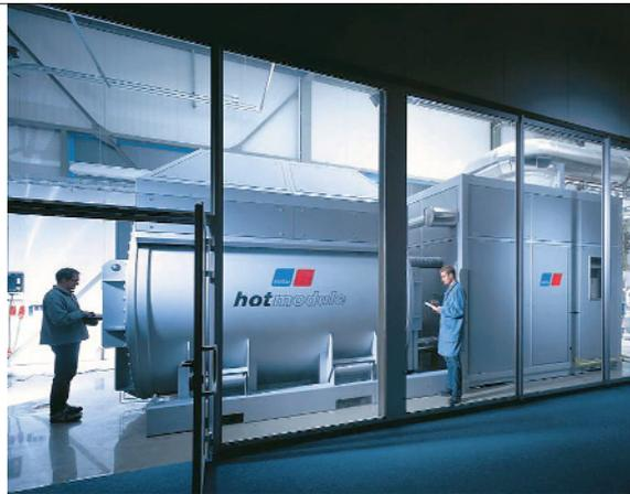
Фото 2. ЭУ фирмы MTU на основе расплавленного карбоната натрия
