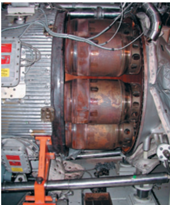
➞ Фото. Осмотр камер сгорания ГТУ SGT-500 (вскрытие во время инспекции уровня В)
