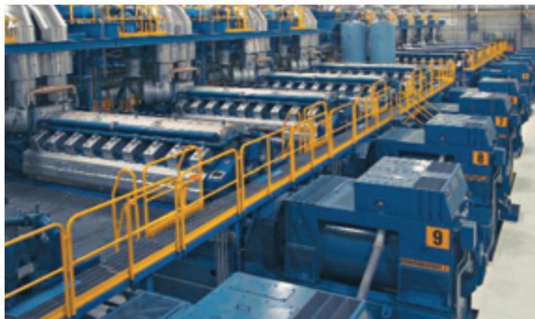
Надежность многоагрегатной станции достаточно высока. Можно гарантировать, что станция выйдет на 90-процентную нагрузку в течение 10 минут. Если бы в состав станции мощностью 100 МВт входила только одна газовая турбина, то на полную нагрузку она вышла бы в течение 15 минут. Однако в 5-10 пусков (из 100) она не сможет выйти на номинальную мощность. При использовании нескольких газовых двигателей станция практически во всех случаях выходит на нагрузку более 80 % в течение 10 минут.
