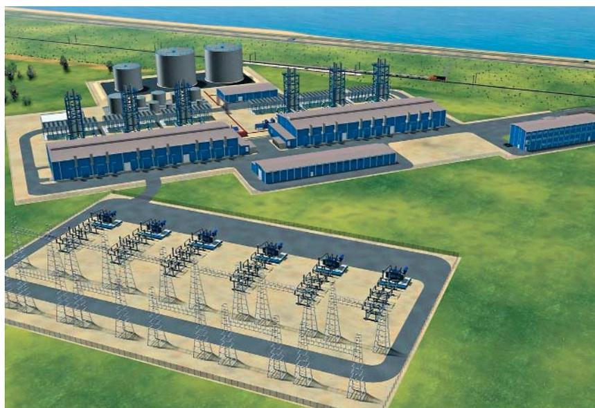
сии. Поскольку жилые дома находятся в 300 м от объекта, на энергоблоках установлены дополнительные системы шумоглушения и дымовые трубы высотой около 36 м.
