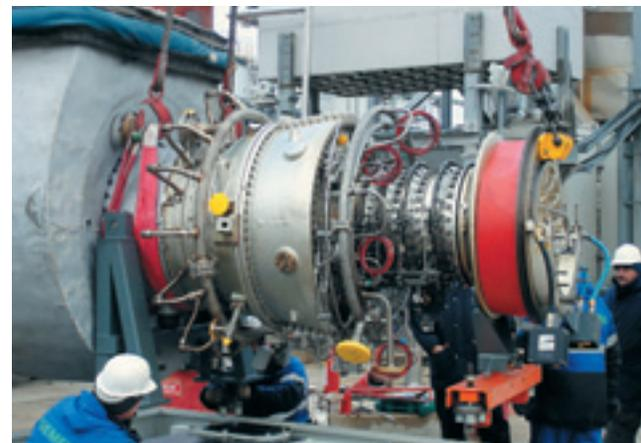
Фото. Демонтаж газовой турбины SGT-100 для проведения инспекции
