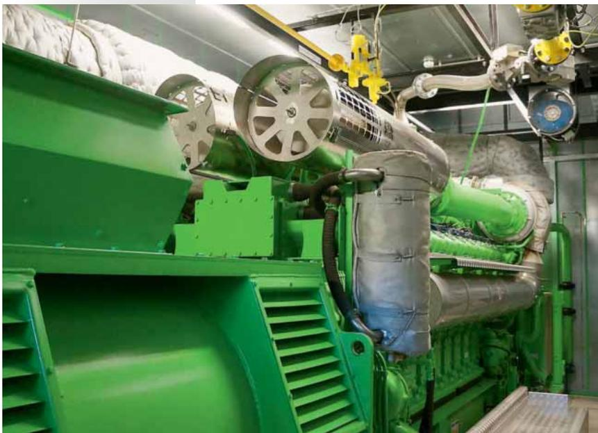
☞ Газопоршневая установка GMS 620 имеет КПД 45 %
