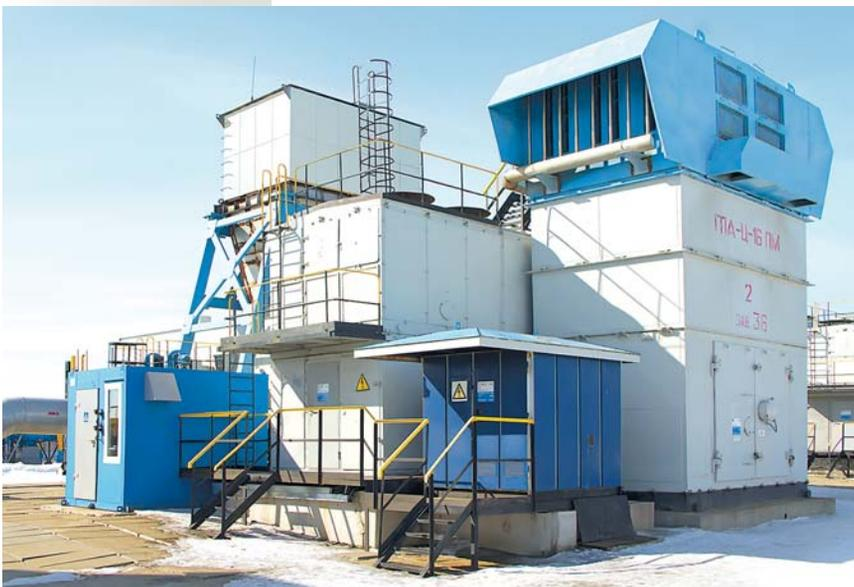
Газоперекачивающий агрегат ГПА-Ц-16ПМ на базе газотурбинной установки ГТУ-16ПМ, оснащенной малозмиссионной камерой сгорания, КС «Чайковская»
