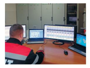
ных установок в единую систему диспетчеризации. Операторный пульт управления энергоцентром включает четыре APM: начальника ПДС, оператора генерации, оператора ГТЭС, оператора ГПЭС. АСУ допускает подключение нескольких удаленных рабочих мест для контроля работы энергоцентра без возможности управления.
