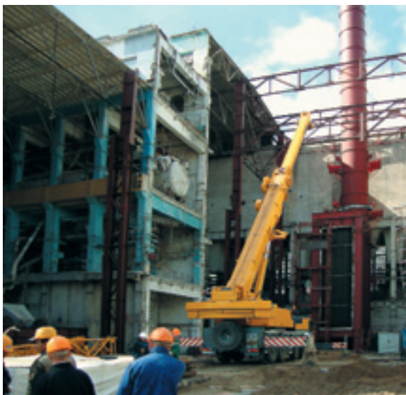
С Монтаж фундамента ГТУ на месте блока среднего давления ТЭЦ-2
