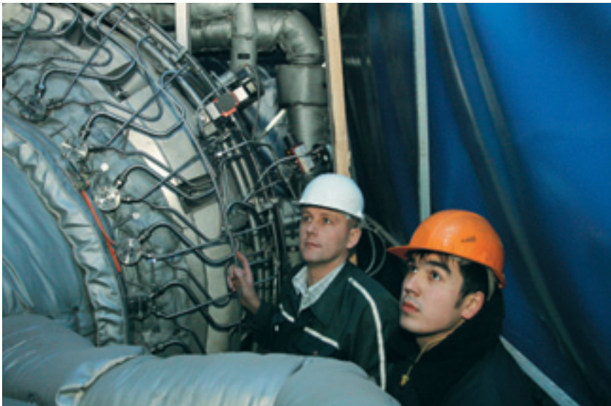
Пусконаладочные работы на ГТУ SGT-800
